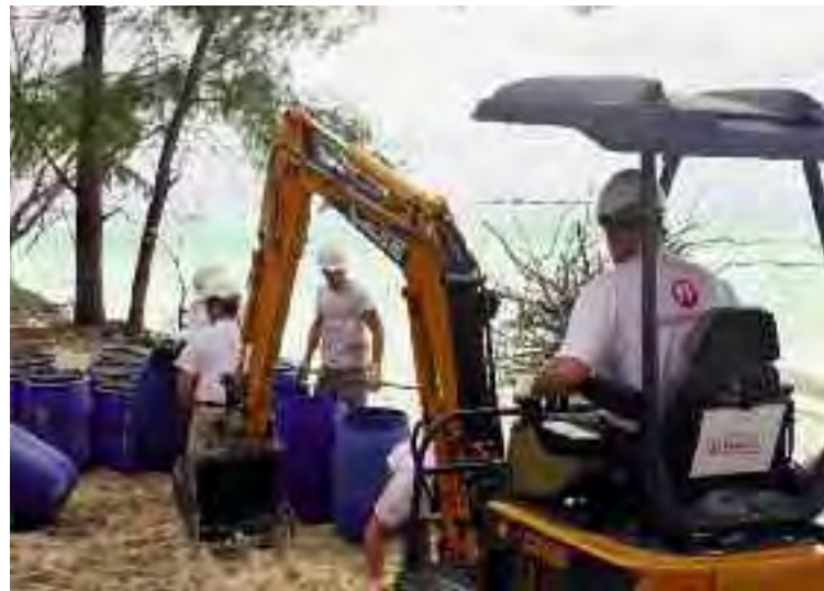
Étape 2: les fûts extraits du sable sont placés dans des contenants hermétiques. Toute la difficulté consiste à éviter l'écrasement des fûts et/ou le déversement du goudron...
