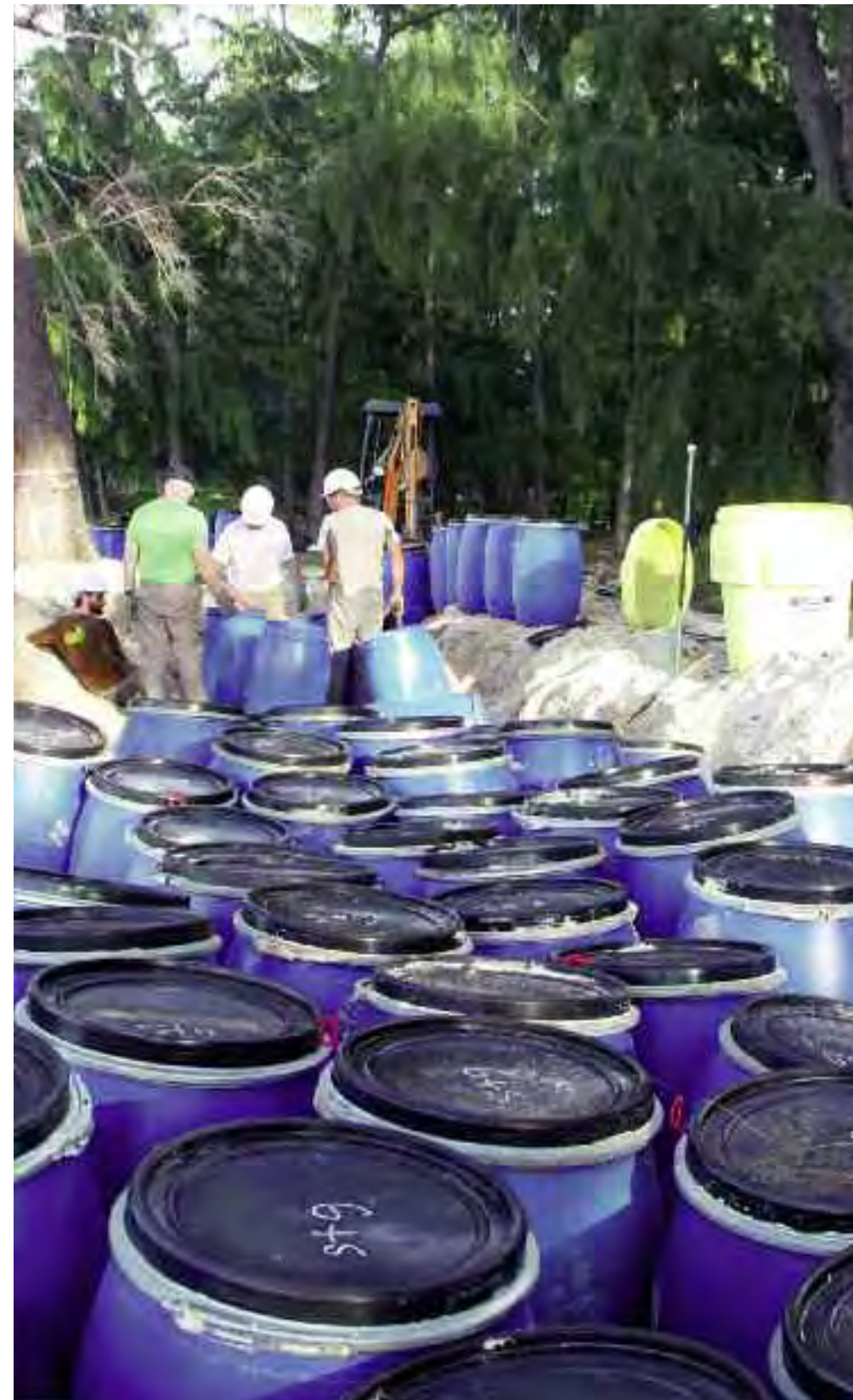
Étape 1: la pelle permet de désenfouir les fûts hydrocarbonés en évitant au maximum de mélanger le sable sain et le sable souillé.
